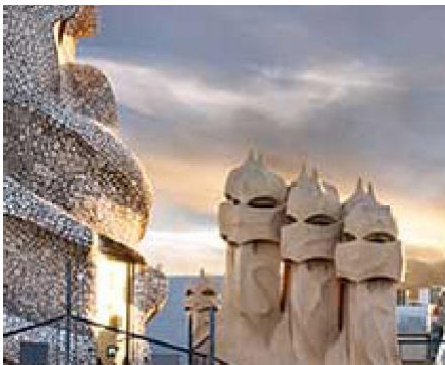
CASA MILÀ (LA PEDRERA)
